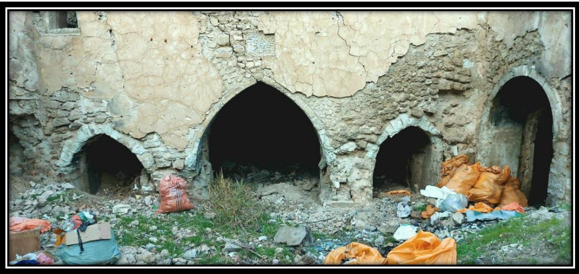
لوح (٧): صور حديثة لمداخل بيت الشهداء كنيسة شمعون الصفا
